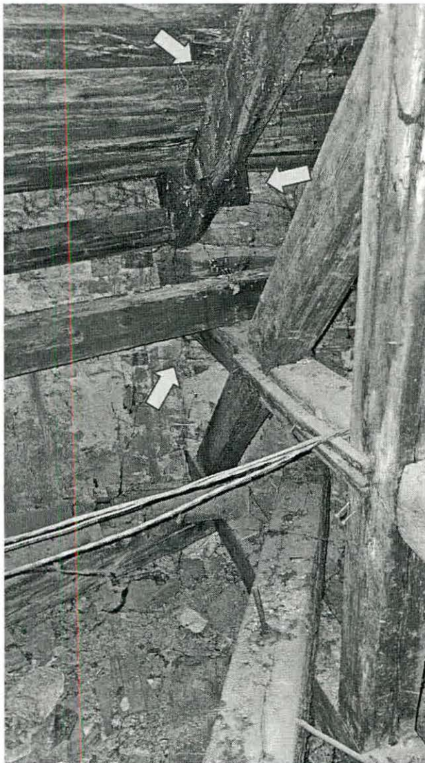
Sarki rész a padlástérből. A lefutó szarukon, élszarukon, deszkázaton, alátámasztó oszlopon és kötőgerendán leázásra utaló elszíneződés és korhadás jelei láthatók. Az oldalfal is ázik, rajta szétfagyott a vakolat, nagy felületen levált.
