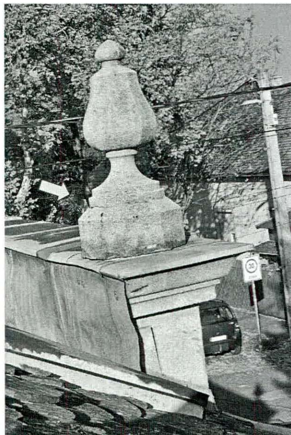
Sarokrész a tetőkibívón keresztül. A műkö dísz alsó részén repedés látható.
