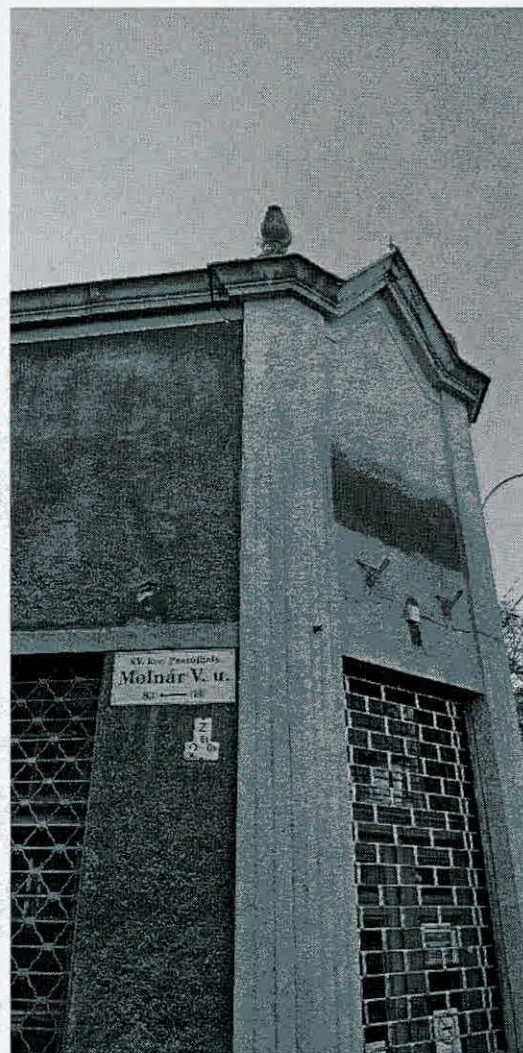
Pestújhelyi utcai oldal. A homlokzaton jelentős elszíneződés, sókiülés látható a vízvezetés rendezetlensége miatt. A sarokrésznél közel függőleges, felfelé megnyíló repedés alakult ki. A repedés maximális mértéke 4-8 mm. A fenti műkö elemek elmozdultak az elmozdulás mértéke cm nagyságrendű.
