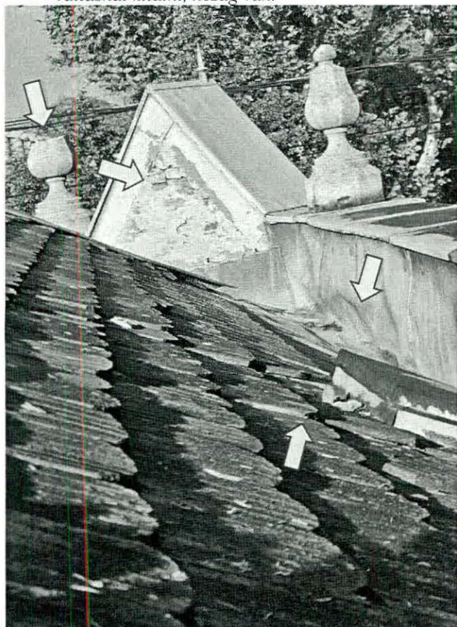
Sarokrész a tetőkibívón keresztül. A műkö dísz alsó részén repedés látható.
