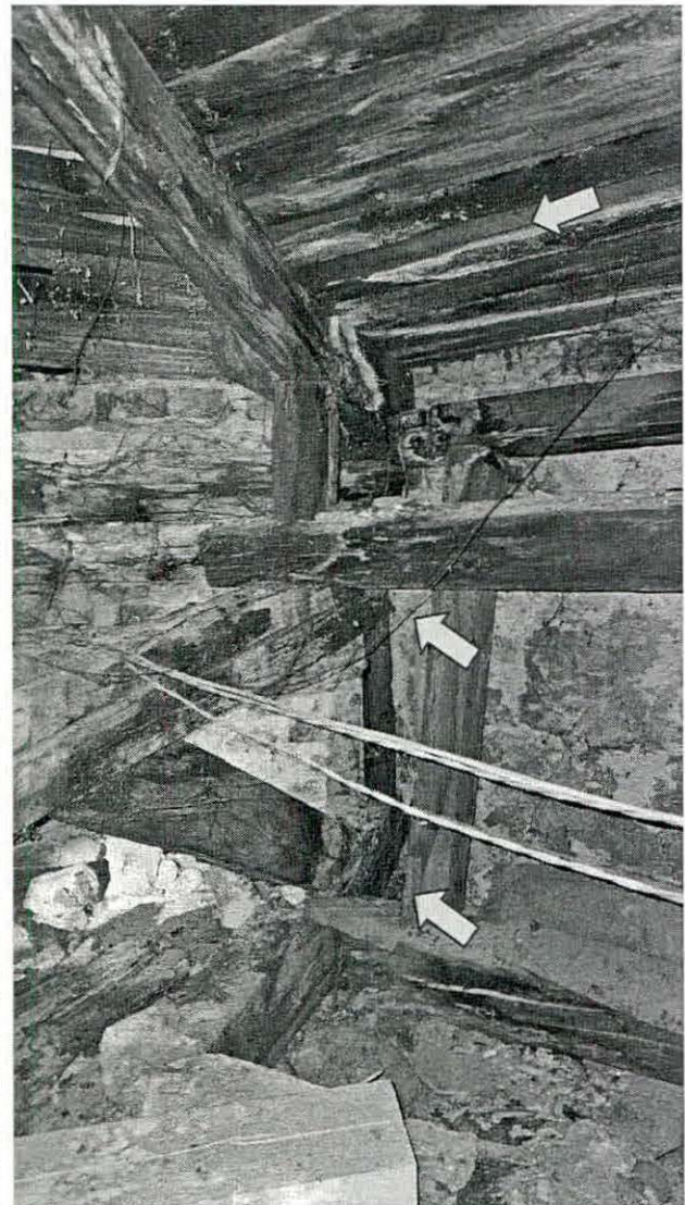
Sarki rész a padlástérből. A lefutó szarukon, élszarukon, deszkázaton, alátámasztó oszlopon és kötőgerendán leázásra utaló elszíneződés és korhadás jelei láthatók. Az oldalfal is ázik, rajta szétfagyott a vakolat, nagy felületen levált.
