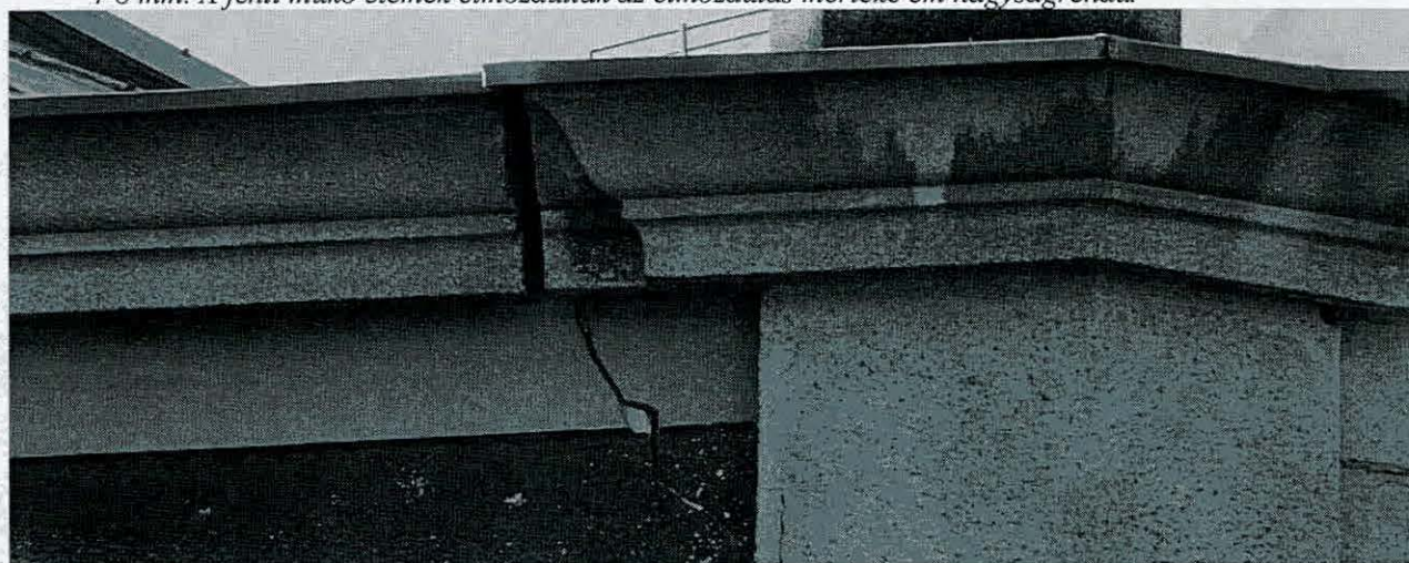
Pestújhelyi utcai oldal. A homlokzaton jelentős elszíneződés, sókiülés látható a vízvezetés rendezetlensége miatt. A sarokrésznél közel függőleges, felfelé megnyíló repedés alakult ki. A repedés maximális mértéke 4-8 mm. A fenti műkö elemek elmozdultak az elmozdulás mértéke cm nagyságrendű.
