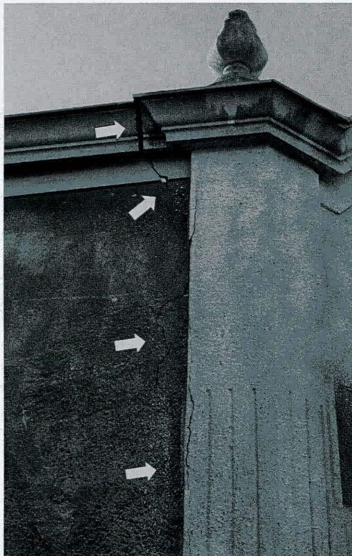
Pestújhelyi utcai oldal. A homlokzaton jelentős elszíneződés, sókiülés látható a vízvezetés rendezetlensége miatt. A sarokrésznél közel függőleges, felfelé megnyíló repedés alakult ki. A repedés maximális mértéke 4-8 mm. A fenti műkö elemek elmozdultak az elmozdulás mértéke cm nagyságrendű.
