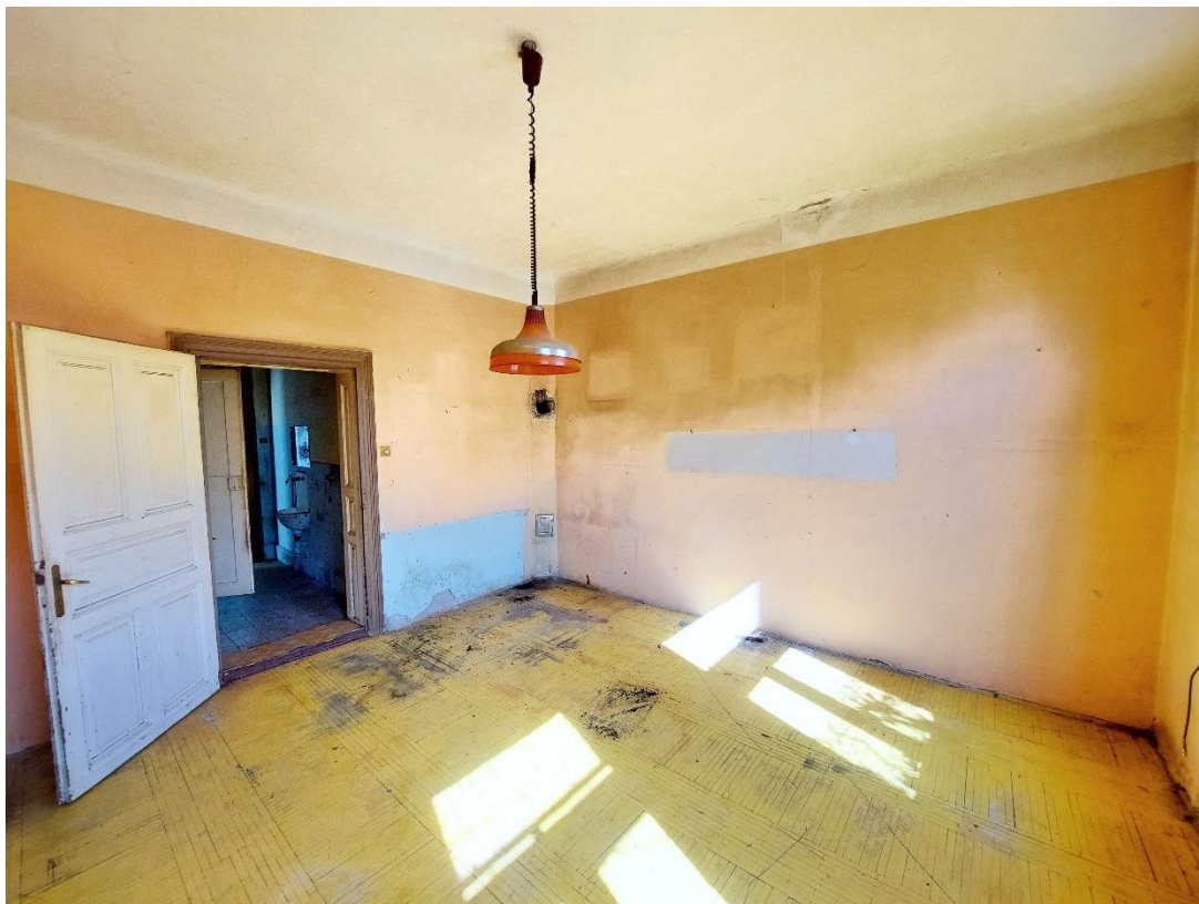
Fsz. 1 lakás szoba helyisége. A padlóburkolat egyenetlen, foltos. A kéménybekötést megbontották
