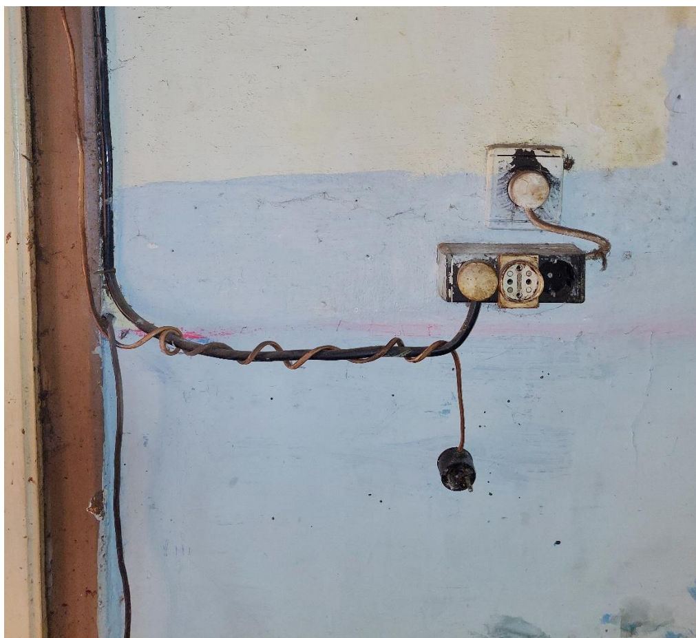
Fsz. 1. lakás. Nem szabványos elektromos hálózat.
