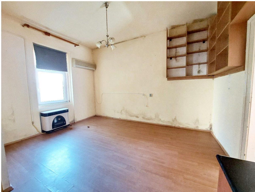
Fsz. 2. lakás konyha étkező helyisége. A gipszkarton előtét falakon látszódik a nedvedesedés.
