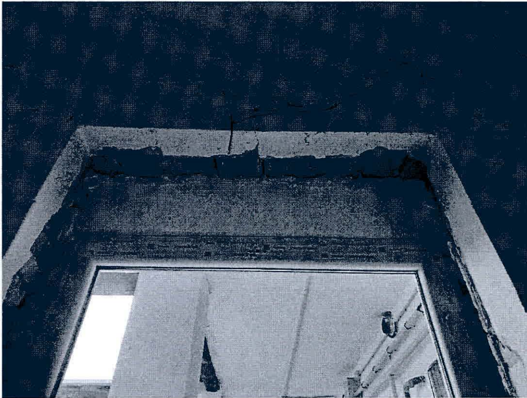
Fsz. 3 lakás szoba helyisége. Az új, hőszigetelt üvegezésű műanyag nyílászárókat beépítették, azonban a méretkülönbségből adódó szerkezeti átalakításokat, valamint a befejező kőműves munkálatokat már nem végezték el.
