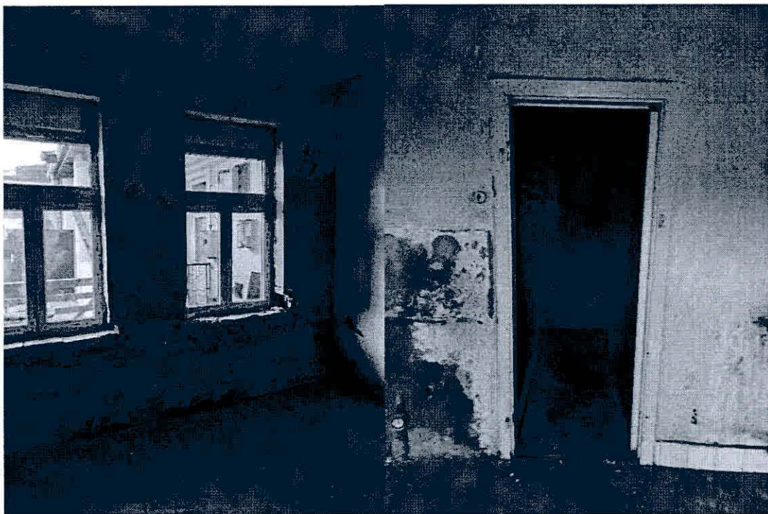
Fsz. 3 lakás szoba helyisége. Az új, hőszigetelt üvegezésű műanyag nyílászárókat beépítették, azonban a méretkülönbségből adódó szerkezeti átalakításokat, valamint a befejező kőműves munkálatokat már nem végezték el.
