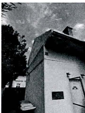
08. részben szigetelt homlokzat
