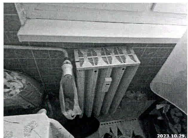
17. radiátor/hőmennyiségmérő
