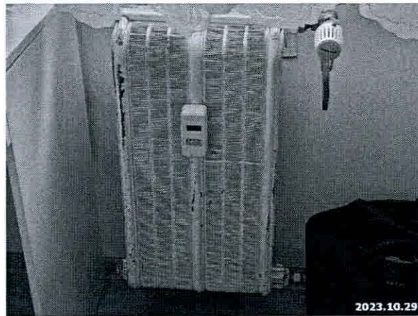
23. radiátor/hőmennyiségmérő
