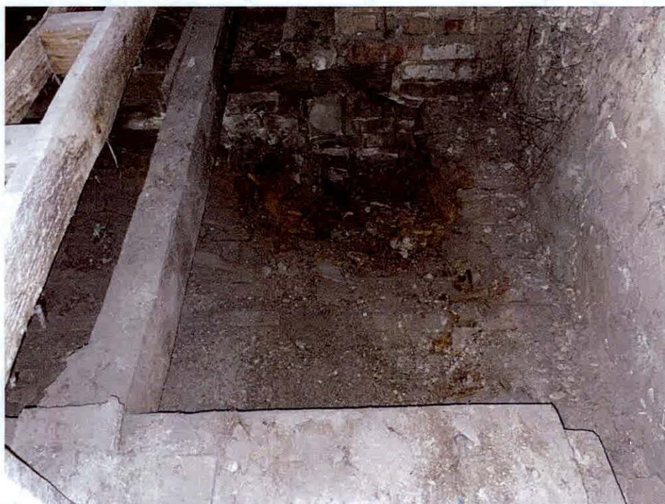
4.sz. kép: Beszakadt deszkázat, korhadt gerendavég az első helyszíni szemlén.
