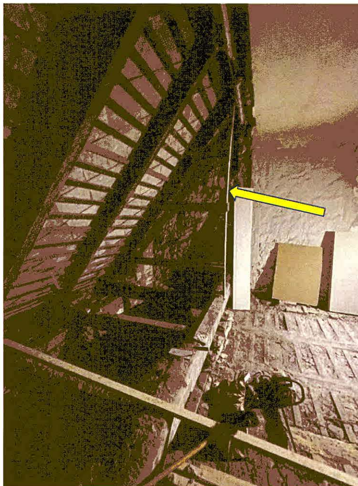
5.sz. kép: Deszkával megtámasztott fiókgerendavég. Deformálódott deszka alátámasztás. A fiókváltó előtti rabcifal elbontásra került.
